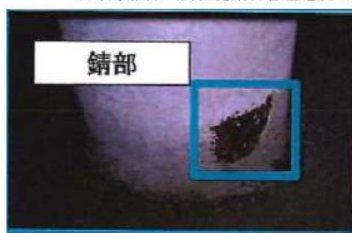
図1 第1貯蔵区域の支柱基部
