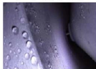
図6 第4貯蔵区域の通風管下部
