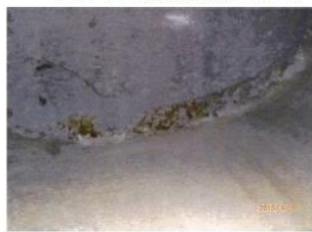
図3 第4貯蔵区域の支柱基部
