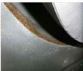
図4 第4貯蔵区域の通風管
