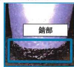
図2 第1貯蔵区域の支柱基部
