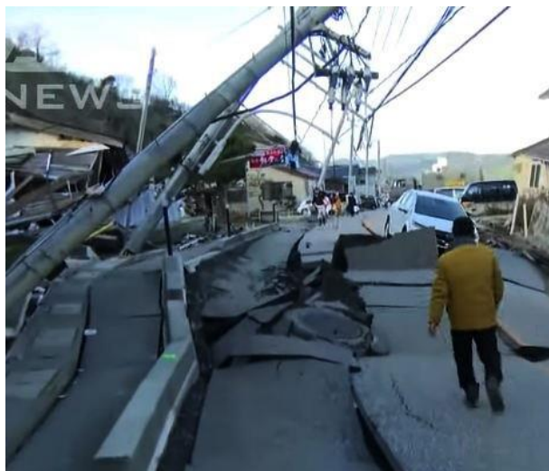
図2 住宅地街路での道路損傷
