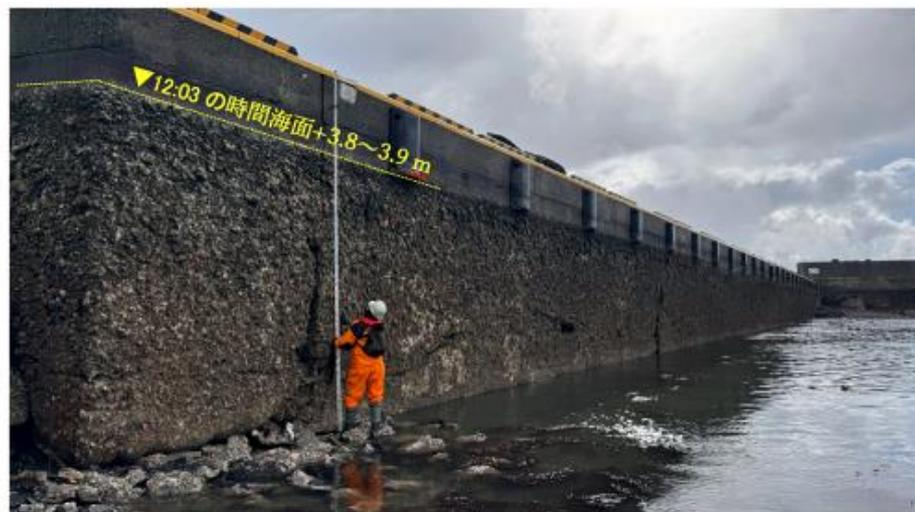
写真1 鹿磯漁港の防潮堤に固着した生物遺骸が示す隆起の様子。人が持っている標尺の長さは5 m
