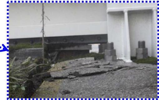
1号機 放水槽及び1号機 補機冷却排水連絡槽防潮壁の基礎の沈下 概要図
