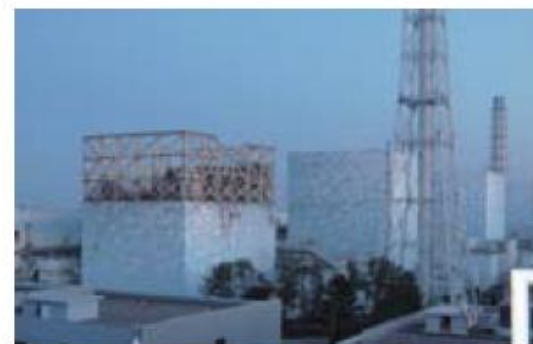
水素爆発直後の1号機原子炉建屋
