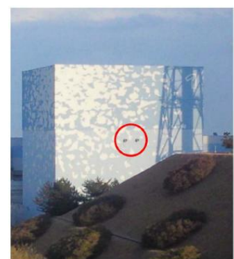
ICのベント管の設置位置
